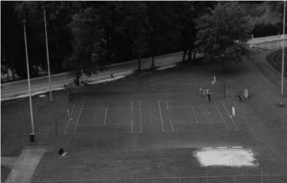
Die letzte Sanierung fand im Jahre 2004 statt. Die Beschichtung und Linierung wurde damals neu gemacht. Nach 17 Jahren Betrieb weist der Allwetter/Basketballplatz an einigen Stellen erhebliche Schäden auf. An mehreren Stellen löst sich bereits die Granulatbeschichtung ab und es bilden sich bereits vereinzelt Risse. Die Lebensdauer eines Kunststoffbelags liegt bei 10 bis 15 Jahre (abhängig von Pflege).
