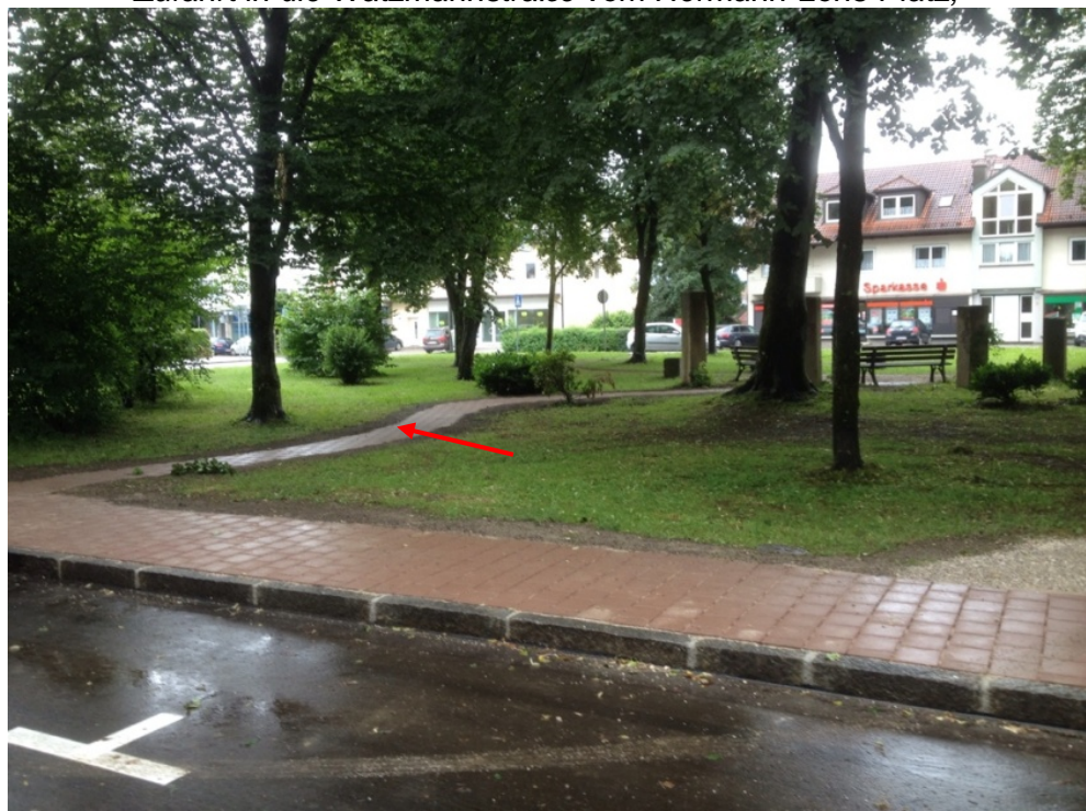
Gehweg mit Betonsteinpflaster; neuer Zugangsweg zu den Bänken und Stelen;
