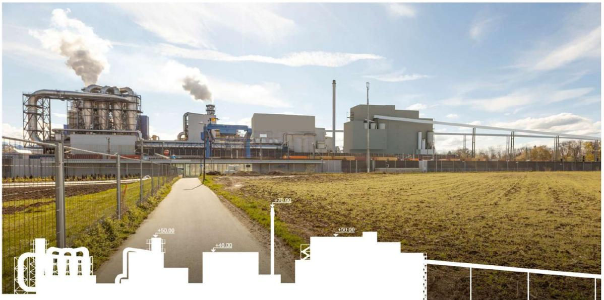
Abb. 6: Fotomontage mit Ansicht des Werkes aus Nordosten. Das 50 m hohe Kraftwerksgebäude befindet sich rechts. Der 70 m hohe Kamin wird den höchsten Punkt des Werkes bilden (Quelle: M. KAINDL GmbH 2022).
