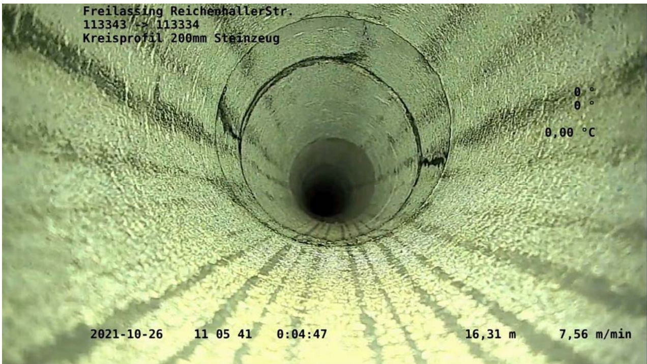
Quartal-Brüche –Scheitel, rechte und linke Seite, Sohle – statische Überlastung
