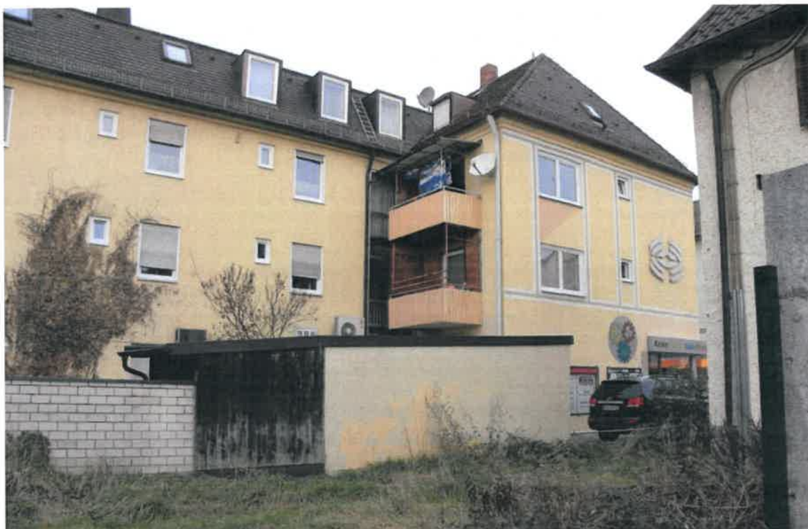
Abbildung 10: Ostansicht Gebäude Fl.Nr. 261 (Foto: Architekturbüro Meier, 15.12.2016)
