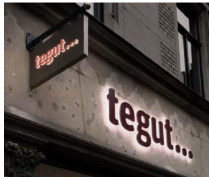
Mit LED hinterleuchtete Metallbuchstaben und schlanker Ausleger (mit LED hinterleuchteter Schriftzug)
