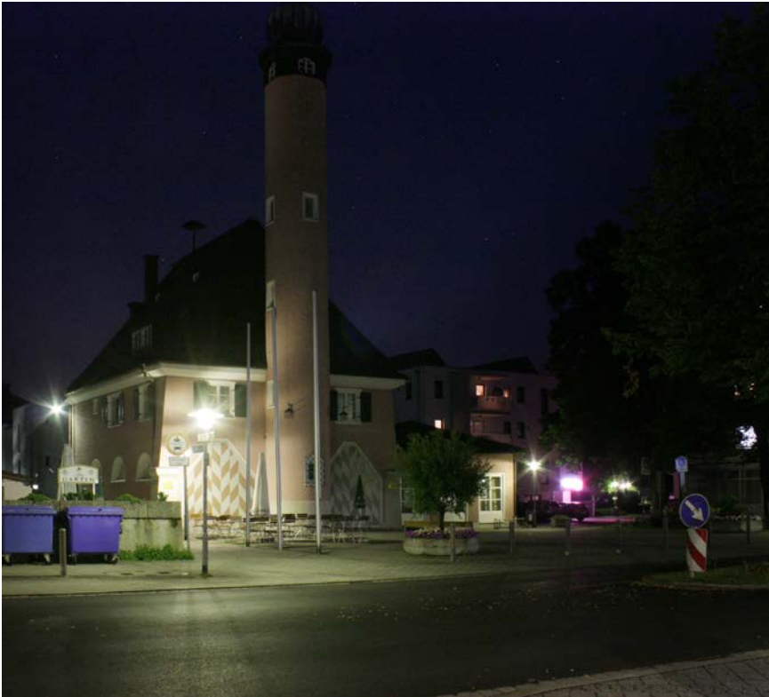
Stadtmuseum | Hermann-Ober-Platz: Derzeitige Beleuchtungssituation
