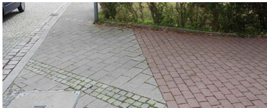
Virgiliusstraße – eine Mixtur aus verschiedenen Steinarten, Steinformaten und Verlegearten
