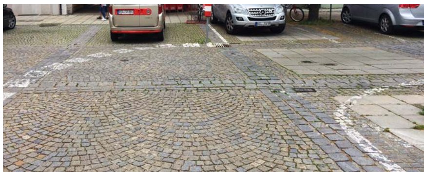
Südliche Hauptstraße | Diffuse Anordnung der Bodenbeläge und nachträgliche Kennzeichnung der Verkehrsführung
