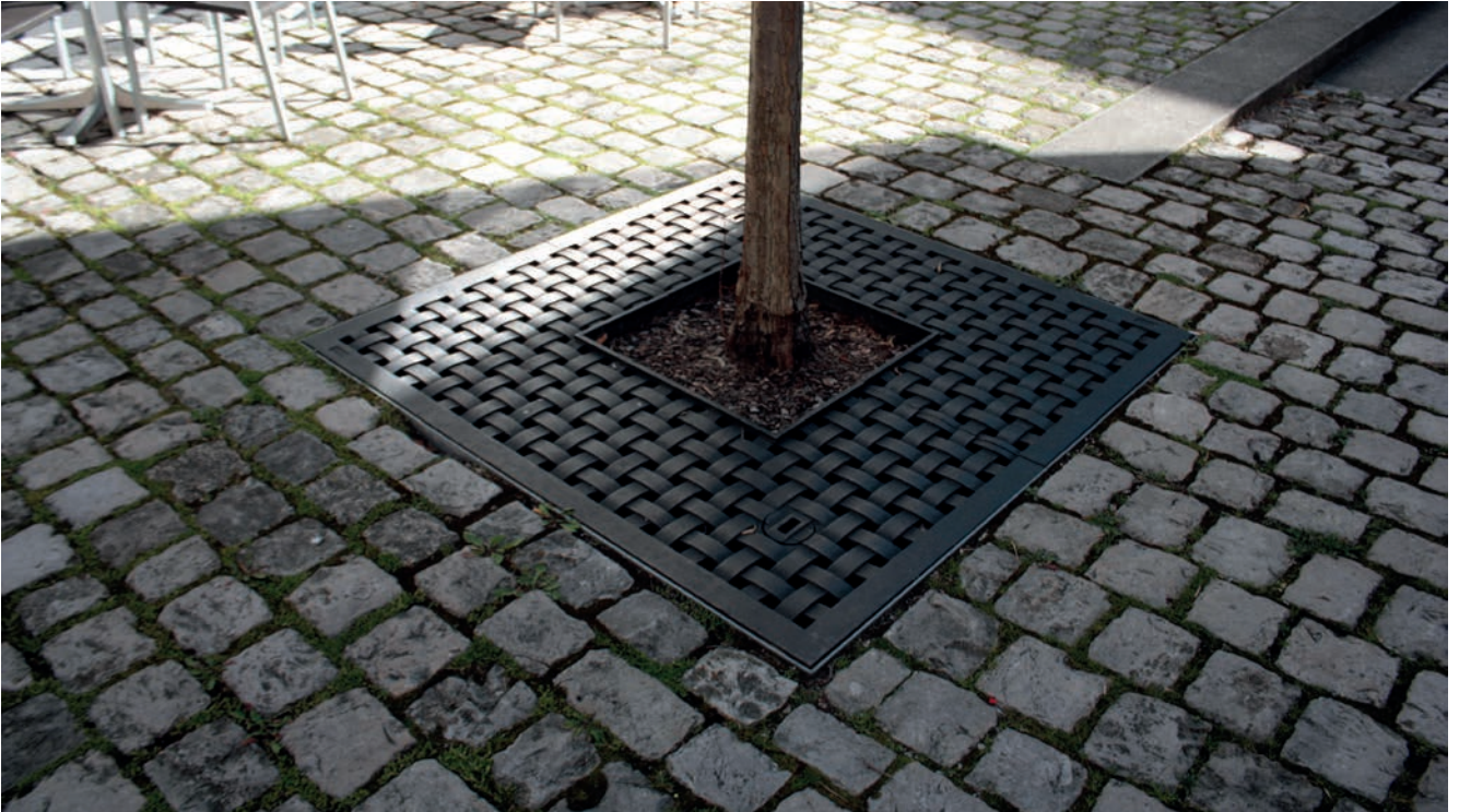
Schutz der Bäume im öffentlichen Raum durch eckige oder runde Baumscheiben oder Baumroste z.B. von Fa. Hess oder MeierGuss Limburg GmbH
