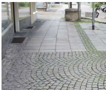
Barriere für Fußgänger durch Belagswechsel
