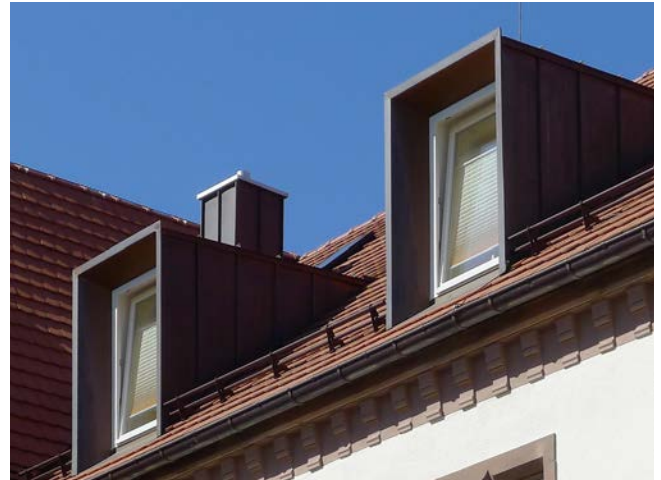
Moderne Kastengauben mit schlankem Wandaufbau und matter, dunkel beschichteter Metallverkleidung
