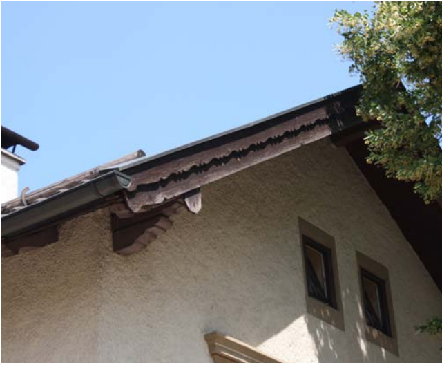
Traditionell weit auskragende Dachüberstände sind eher selten anzutreffen
