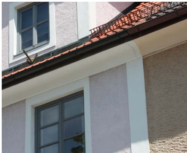
Traubereich mit angeputzter Hohlkehle
