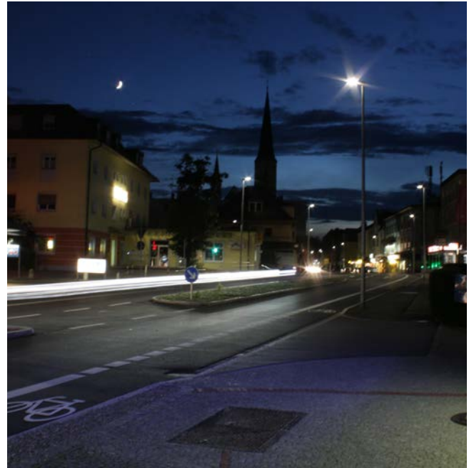
Pfarrkirche St. Rupert: Wer ist hier prominent – der Straßenraum oder das Baudenkmal?
