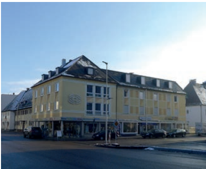
Mittlerer Gebäudezustand, Münchener Str.
