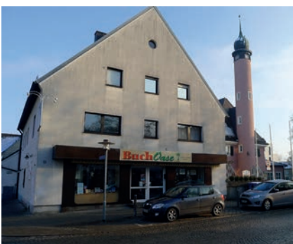
Schlechter Gebäudezustand, Lindenstr.
