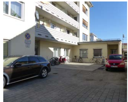
Hoher Versiegelungsgrad, Lindenstraße
