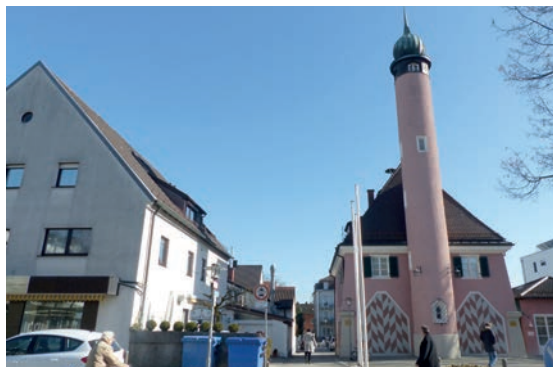
Bestandssituation, Altes Feuerwehrrhaus
