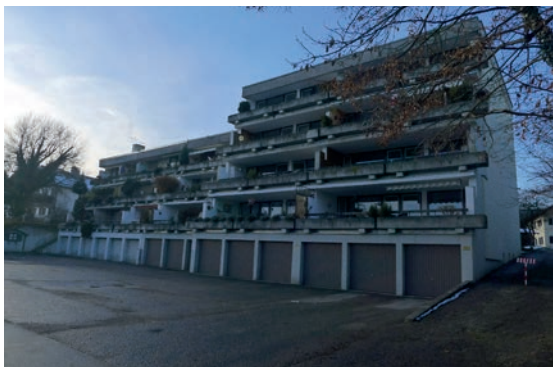
Bestandssituation Richtung Leitenweg
