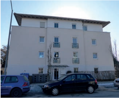
Guter Gebäudezustand, Fürstenweg
