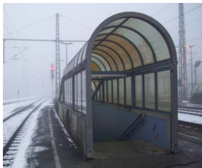
Gestörte Verbindung | Treppenaufgang Unterführung Bahnsteig
