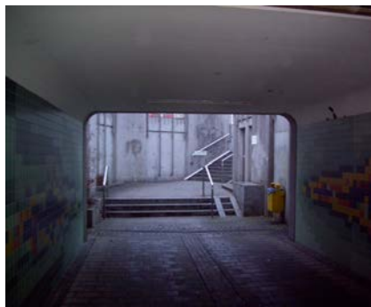
Gestörte Verbindung, Unterführung
