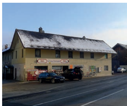
Schlechter Gebäudezustand, Ludwig-Zeller-Str.
