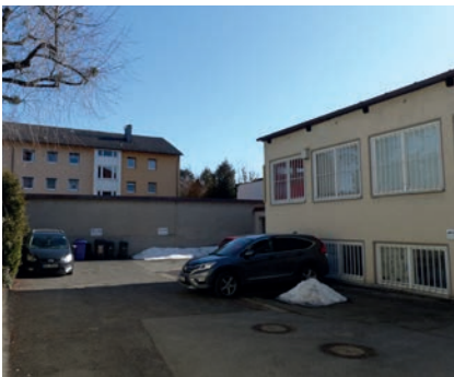
Versiegelter Hinterhof, Hauptstraße
