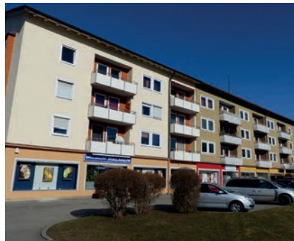
Mittlerer Gebäudezustand, Münchener Str.
