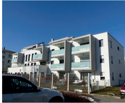
Guter Gebäudezustand, Jahnstraße
