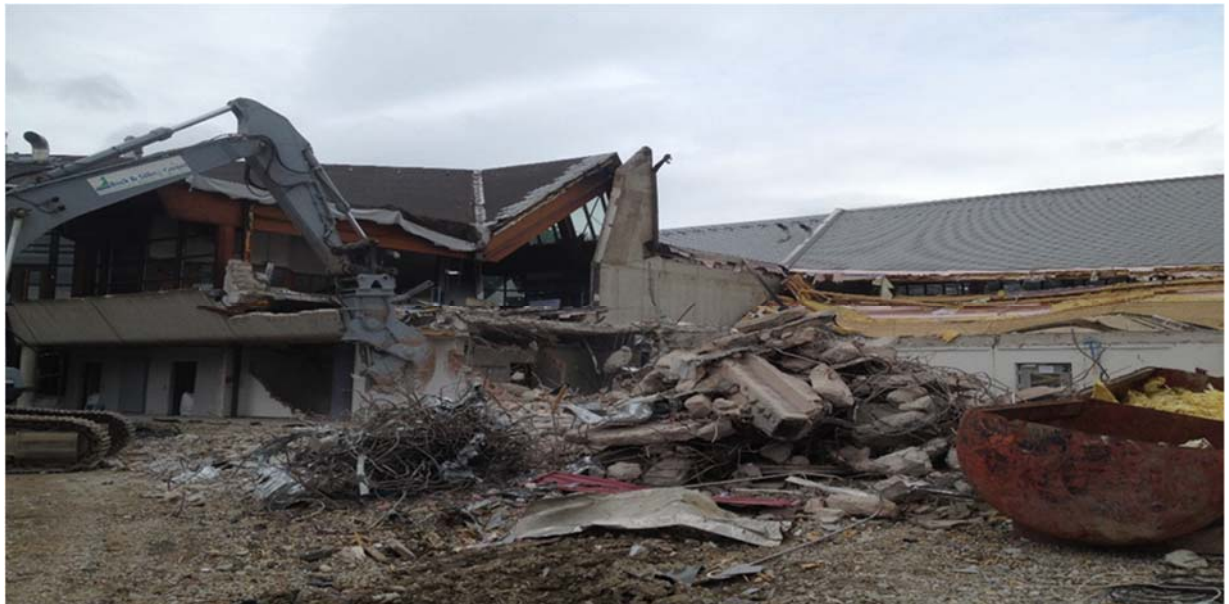
Bild 2: Die Abbrucharbeiten im Juli 2016 im vollen Gange
