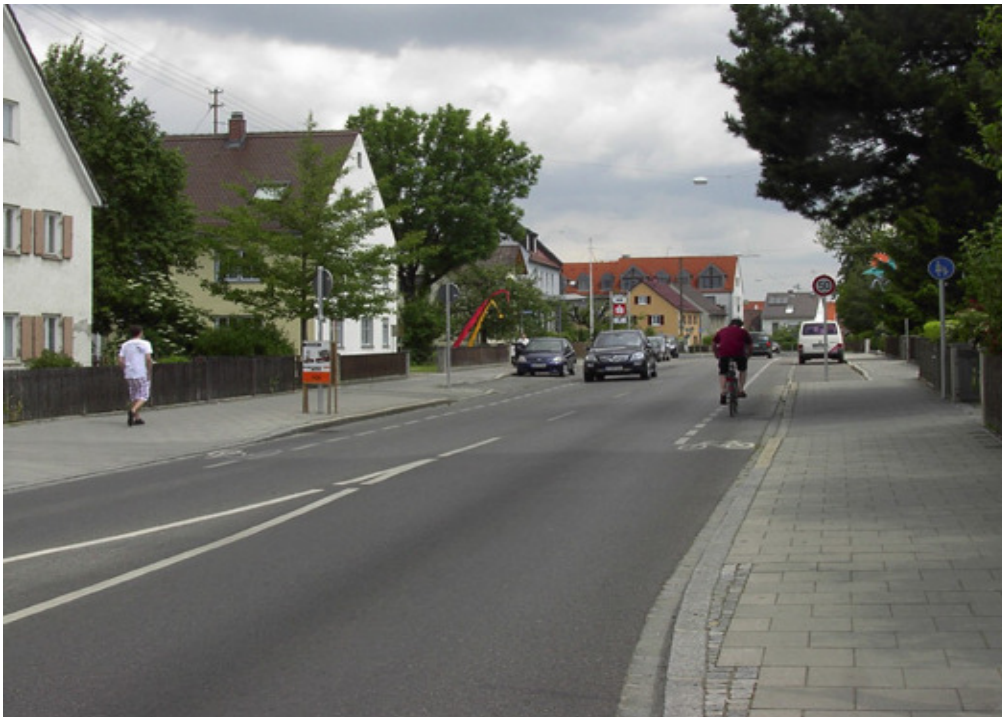
Kreiselausfahrt am Knoten Hochstraße / Maria-Hilf-Straße in Bobingen
