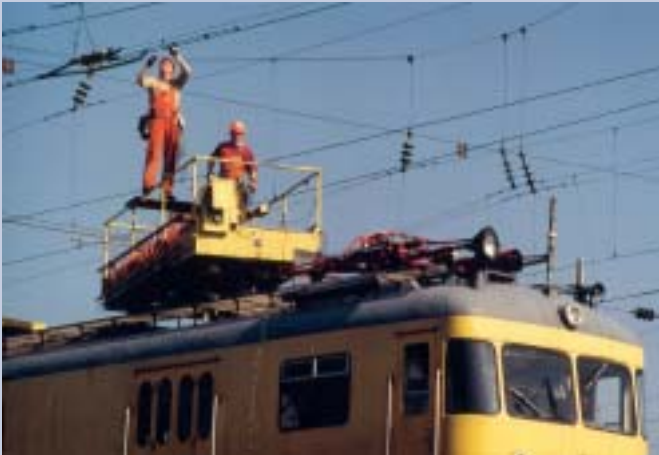
3. Platz - Otto Schmidt, Freilassing Reparatur der Fahrleitung in Freilassing
