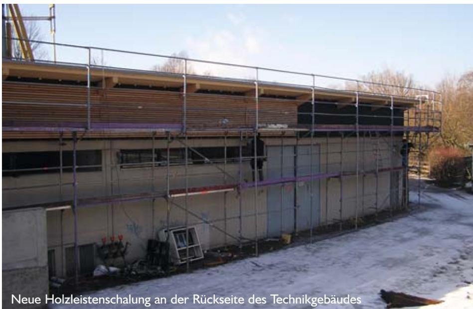
Neue Holzleistschalung an der Rückseite des Technikgebäudes
