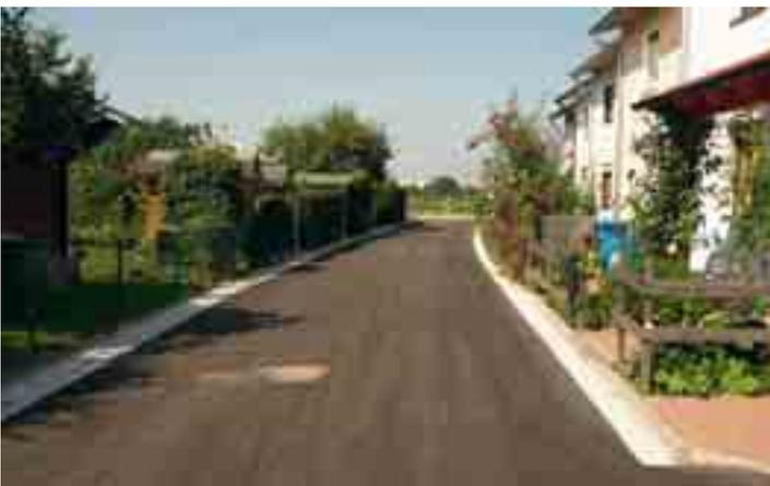
„4 auf einen Streich“! Gleich **vier Straßen wurden heuer in einem Zug endausgebaut**. Im Lilien-Rosen-, Tulpen- und Veilchenweg rollten die Bagger für die Erneuerung der Wasserleitung und der Straßenoberflächen inklusive einer funktionierenden Straßenentwässerung.
