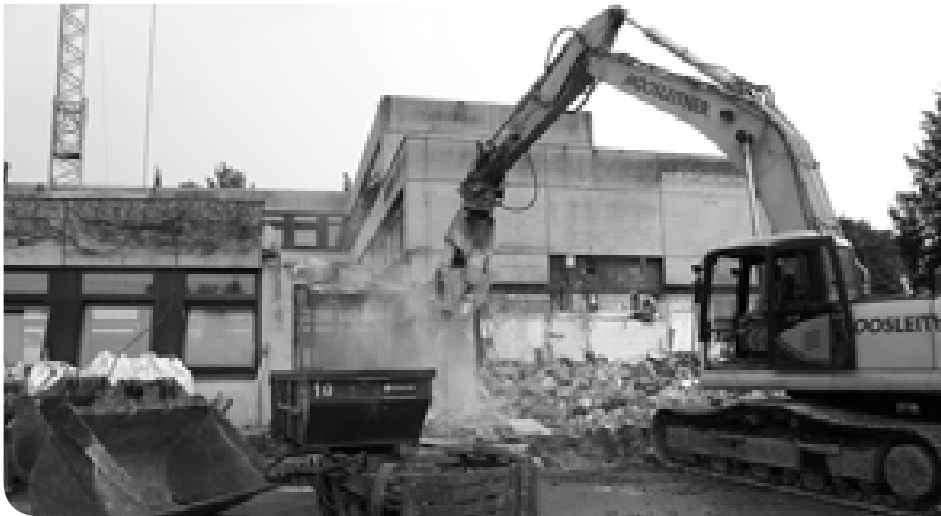
Abbrucharbeiten an der Nord-West-Seite des Hauptschulgebäudes.
