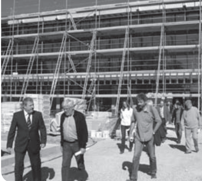
Der Freilassinger Stadtrat machte sich bei einer Besichtigung selbst ein Bild vom Fortschritt der Bauarbeiten
