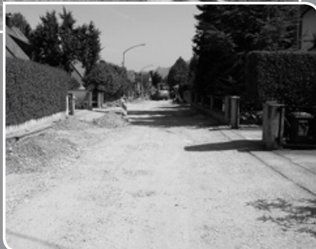
Baumaßnahme Garten- und Kirchfeldstraße: Nach Fertigstellung des Wasserleitungsbaus mit den Hausanschlüssen wurde mit dem Straßenausbau begonnen. Beide Straßen sollen noch im Oktober 2011 fertig ausgebaut sein.
