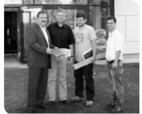
Bürgermeister Josef Flatscher (l.) und Markus Hiebl (r.), städt. Bauamt, besichtigten gemeinsam mit Architekt Fred Meier (2.v.l.) und Matthias Engel (2.v.r.), ArGe Fred Meier & Bernhard Putzhammer, die Baustelle.
