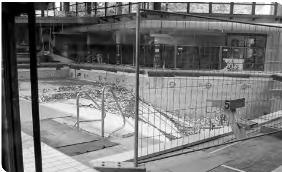
Die Fliesen wurden bei den 35 Jahre alten Becken komplett abgeschlagen.
