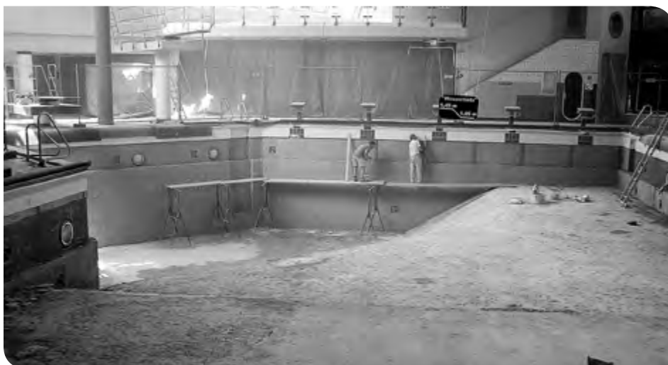
Der neue Boden und Wandaufbau wurde mit zeitgemäßer Abdichttechnik eingebracht.
