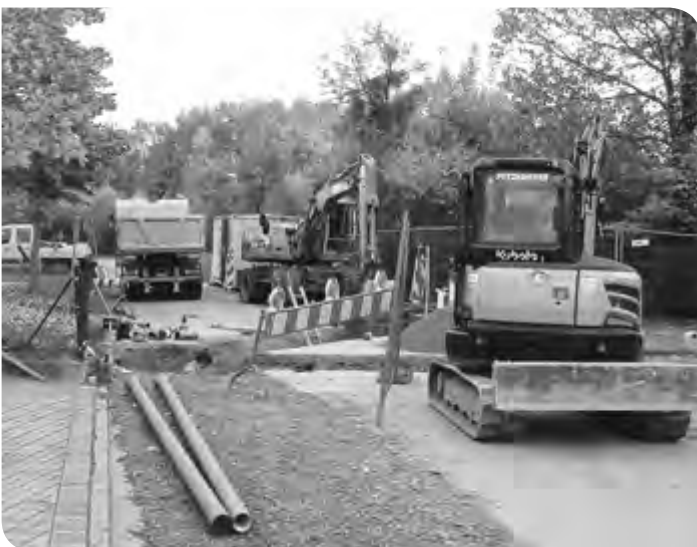
Grabarbeiten der Wasserleitungsverlegung im Anschlussbereich der Reiteralpestraße
