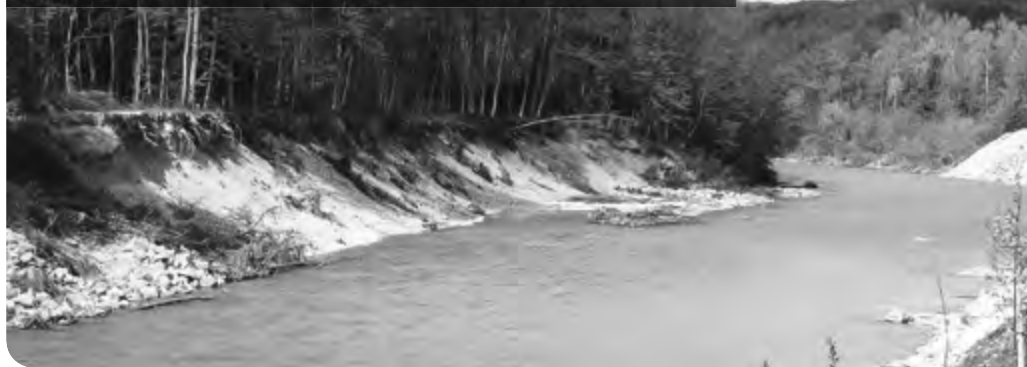
Uferanbrüche im Unterlauf der Saalach, entstanden beim Jahrhunderthochwasser 2013 Foto: Wasserwirtschaftsamt Traunstein
