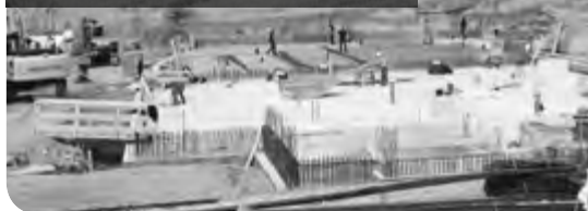
Die Grundplatte für den Technikbereich des Schwimmbades wurde schon Ende April betoniert.
