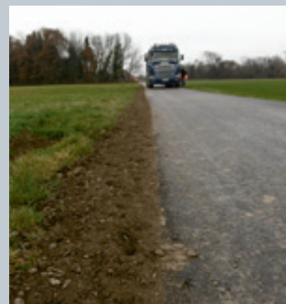
Die Lohenstraße wurde in den letzten Wochen mit eine 3-8cm dicken Asphaltdeckschicht überbaut und ist nun offiziell wieder befahrbar.
