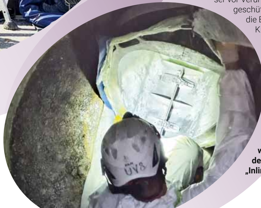
Die Arbeiter der ausführenden Firma machen sich zur grabenlosen Kanalsanierung bereit zum Einstieg in den Kanal.
